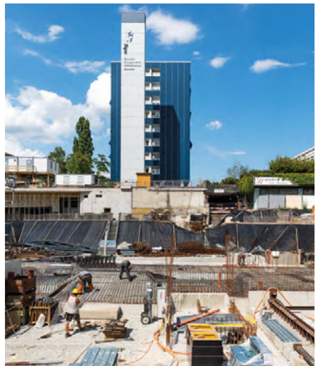
PROJET VVF, VUE DU CHANTIER DES BÂTIMENTS A ET G
