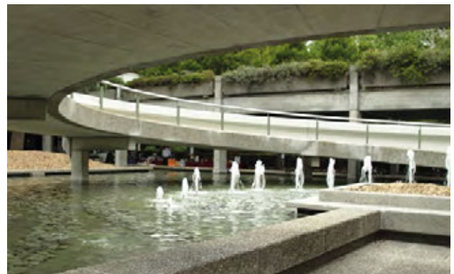
BASSIN DE LA FONTAINE APRÈS RÉNOVATION
